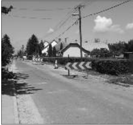
A Felsőjózsi utcában csak lépésben lehet közlekedni.
