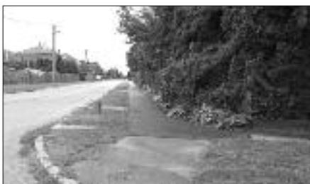
Több helyen járdafelújítást is végeztek Józsan - képünk a Felsőjózsi utcán készült.
