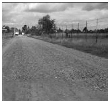
A Barakonyi utca vége évek óta kaotikus volt esőzések után. Az útstabilizálást követően könnyebben és gyorsabban megközelíthető a Vállalkozói telephelyek.
